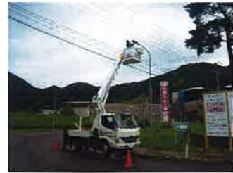
外灯の作業中です
